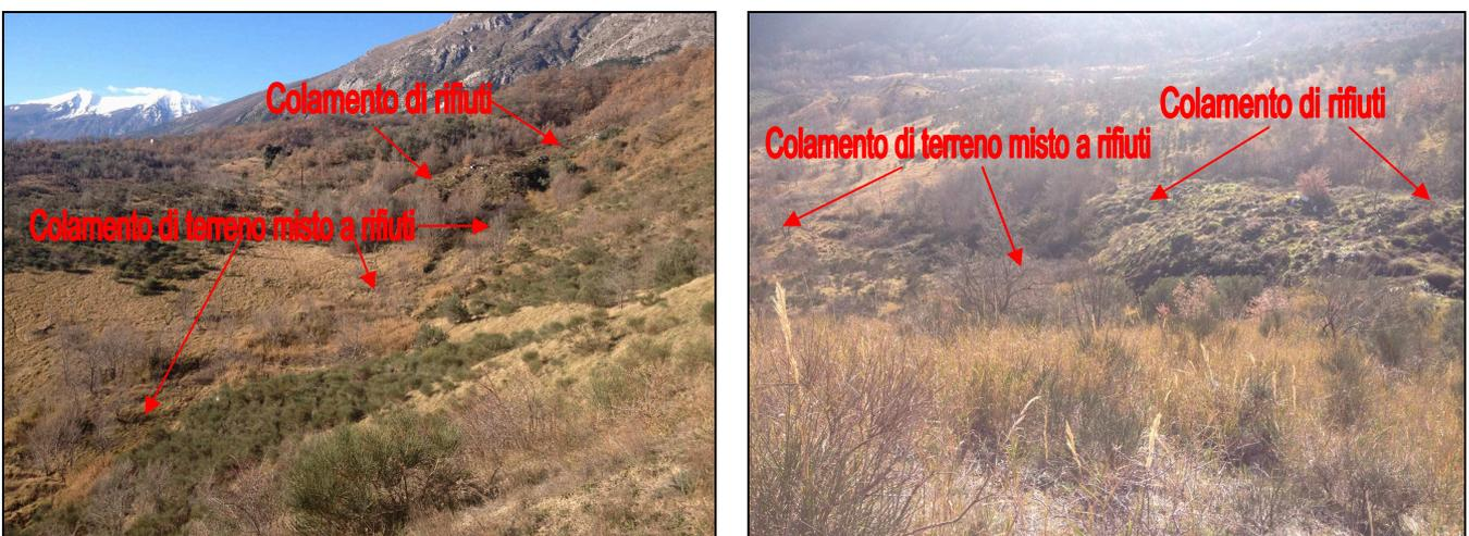
**Fig. 9:** Particolari del colamento di terreno misto a rifiuti.
